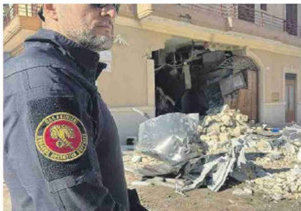
La devastazione lasciata dall'assalto con un escavatore all'ufficio postale di San Ferdinando di Puglia
